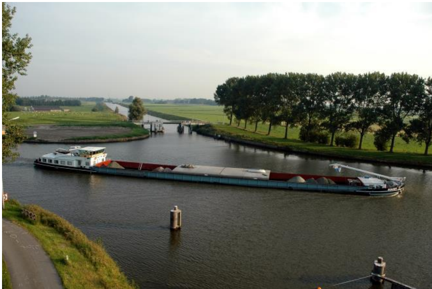
Figuur 4-4: Het Van Starckenborgkanaal doorsnijdt het Reitdiep (Bron: Albert Jan Scheper)
