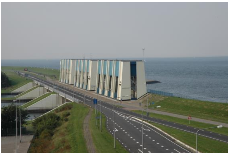
Figuur 4-2 : Cleveringsluizen bij Lauwersoog (Bron: Albert Jan Scheper)
